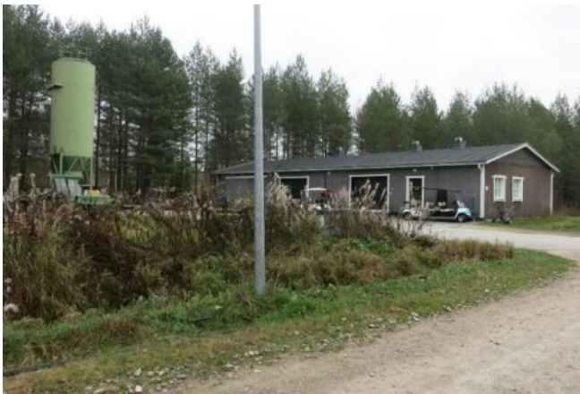
Junaradan lähellä Golftien loppuosassa oleva varistorakennus
