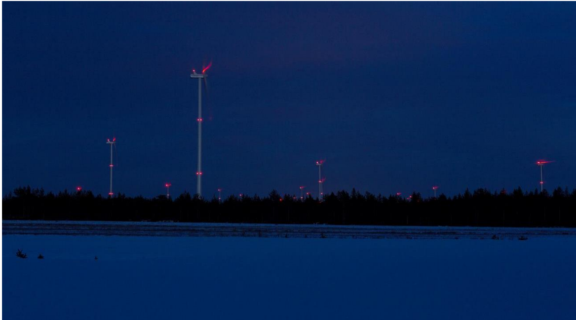
Kuva 95. Kiinteät punaiset lentoestevalot (Ville Suorsa, FCG).
