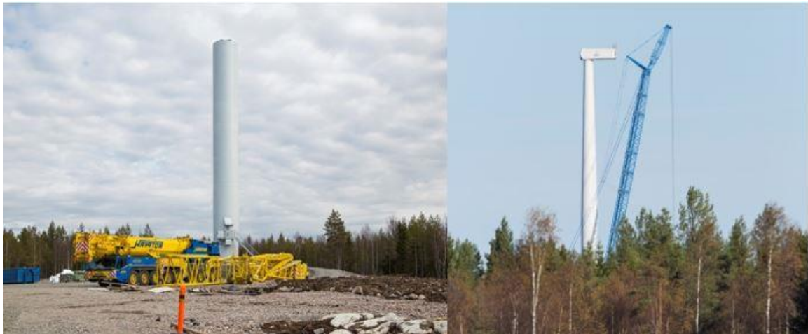
Kuva 103. Tuulivoimalan kokoamista (Ville Suorsa, FCG).
