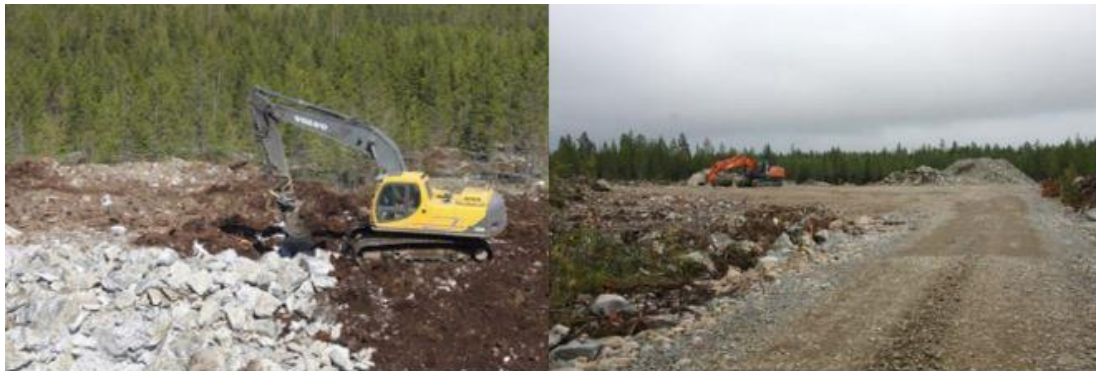
Kuva 100. Tuulivoimapuiston rakentaminen alkaa huoltoteiden ja pystytysalueiden rakentamisella (Ville Suorsa, FCG).
