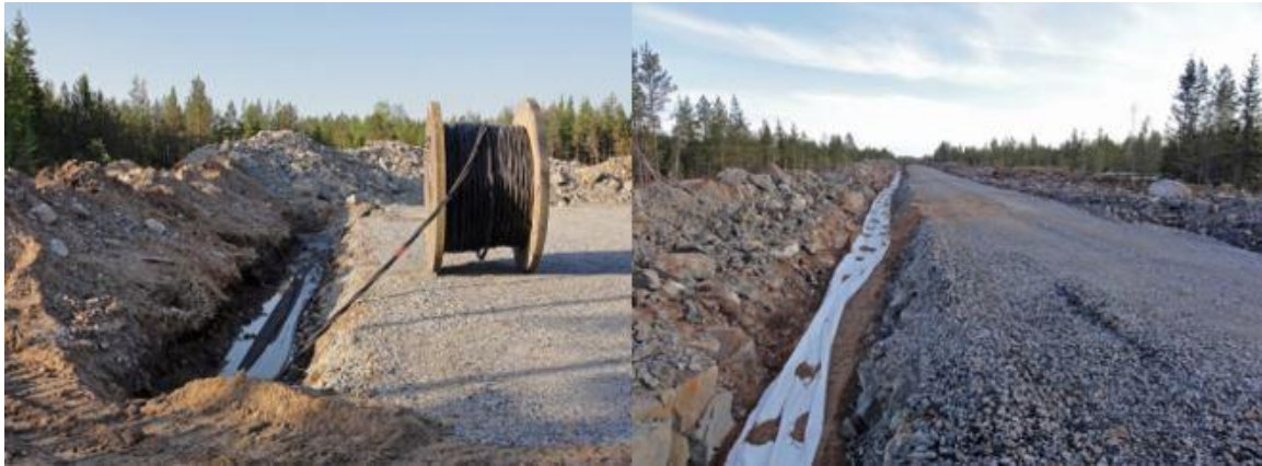
Kuva 101. Maakaapelit upotetaan huoltoteiden yhteyteen (Ville Suorsa, FCG).
