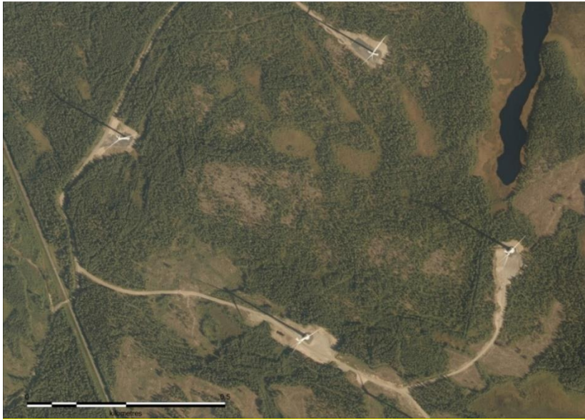
Kuva 91. Esimerkkikuvassa näkyy toiminnassa olevia tuulivoimaloita. Tuulivoimaloita varten on rakennettu huoltotiet ja nostokentät. Tuulivoimaloiden ympäristössä ja välialueilla aikaisempi maankäyttö on säilynyt ennallaan (Maanmittauslaitos).
