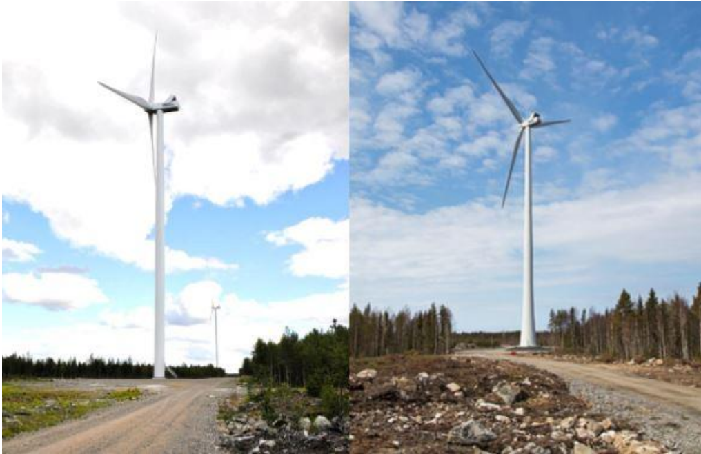
Kuva 92. Vasemmalla on esimerkki teräslieriötornista ja oikealla hybriditornista (Leila Väyrynen ja Ville Suorsa, FCG).
