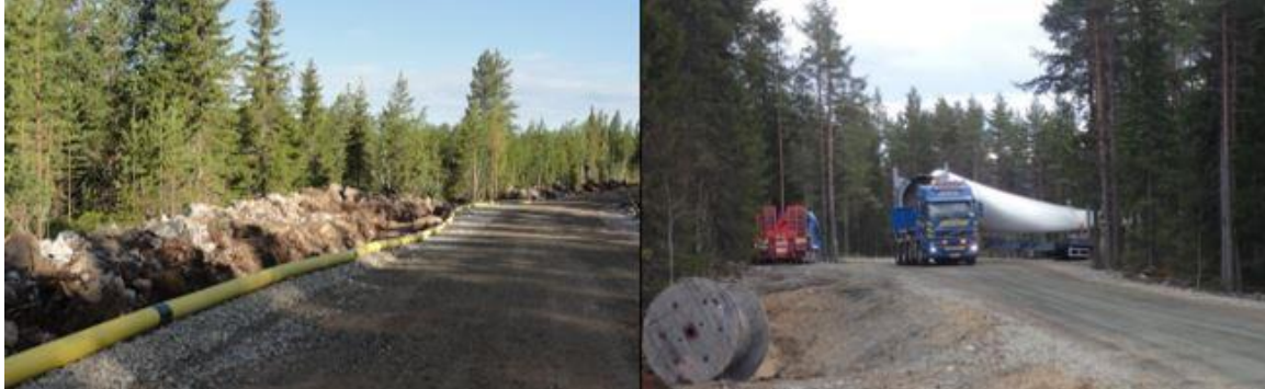
Kuva 99. Vasemmalla esimerkki tuulivoimapuiston rakennus- ja huoltotiestä. Teitä käytetään muun muassa betonin, soran ja voimaloiden komponenttien kuljetuksiin sekä tuulivoimapuiston käyttövaiheessa huoltoajoihin. Maakaapeli sijoitetaan ojakaivantoon tien reuna-alueelle. Oikealla tuulivoimalan osia kuljetetaan erikoiskuljetuksina. (Ville Suorsa, FCG).
