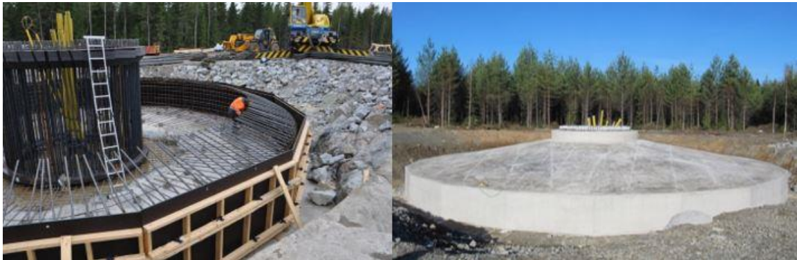
Kuva 102 Tuulivoimalan perustusten rakentamista (Leila Väyrynen, FCG).
