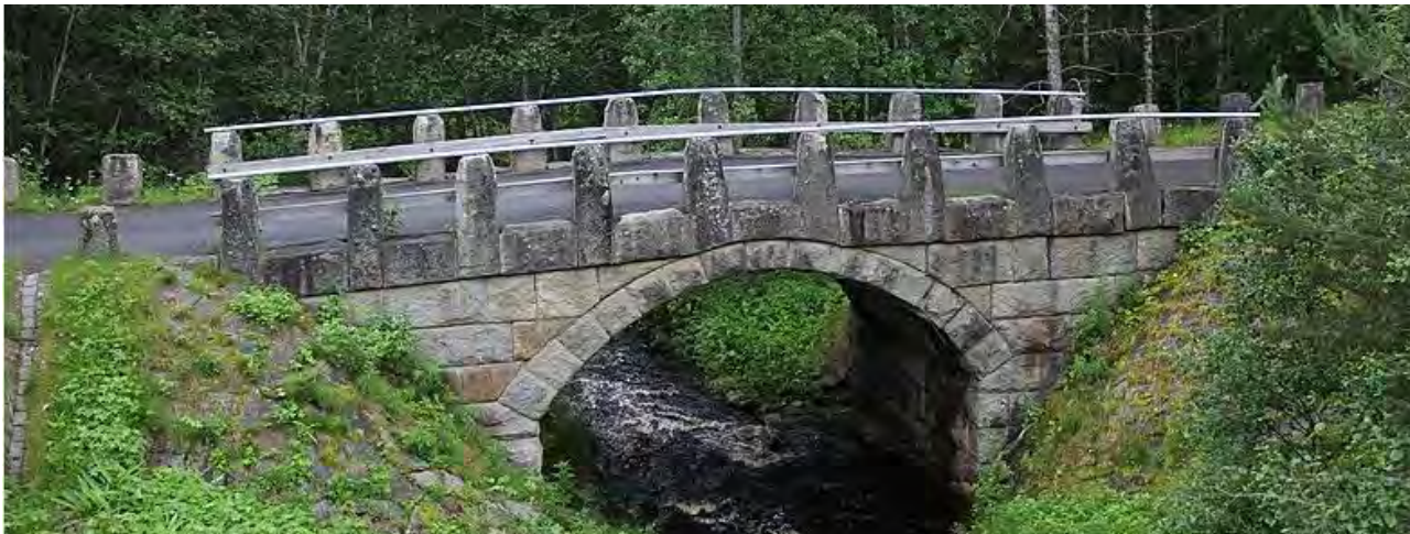
Kuva 6-17: Möykkysenjoen museosilta, Ristijärvi, Suomi. - Silta kuvattuna yhdystien uudelta sillalta (@Htm)
