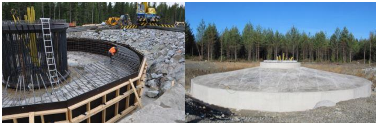
Kuva 101. Tuulivoimalan perustusten rakentamista (Kuvat: Leila Väyrynen, FCG).
