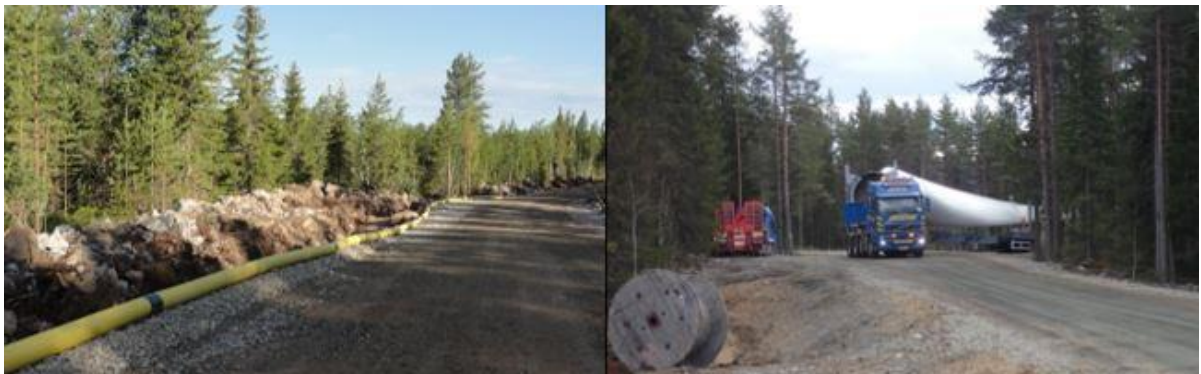
Kuva 96. Vasemmalla esimerkki tuulivoimapuiston rakennus- ja huoltotiestä. Teitä käytetään muun muassa betonin, soran ja voimaloiden komponenttien kuljetuksiin sekä tuulivoimapuiston käyttöväleheissä huoltoajoihin. Maakaapeli sijoitetaan ojakaivantoon tien reuna-alueelle. Oikealla tuulivoimalan osia kuljetetaan erikoiskuljetuksina (Kuvat: FCG).
