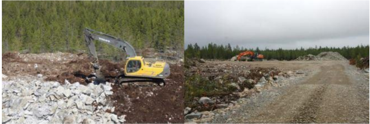
Kuva 99. Tuulivoimapuiston rakentaminen alkaa huoltoteiden ja pystytysalueiden rakentamisella (kuvat: FCG).
