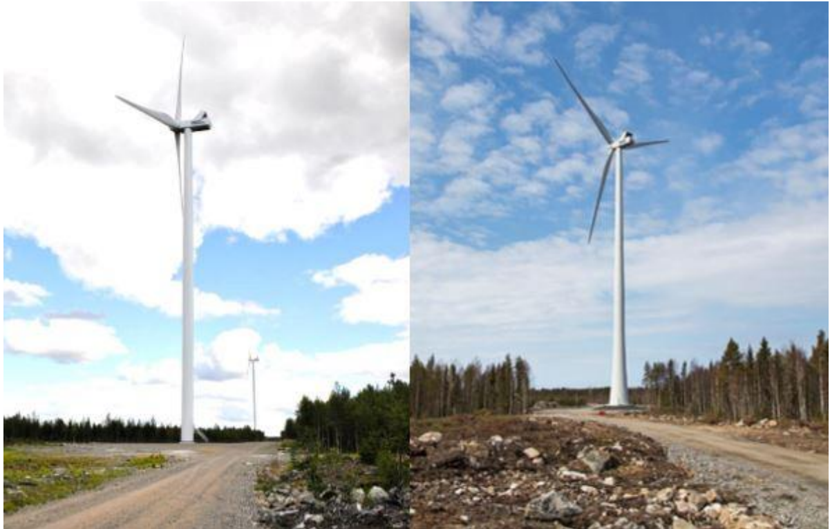
Kuva 90. Vasemmalla on esimerkki teräslieriötornista ja oikealla hybriditornista ( FCG).
