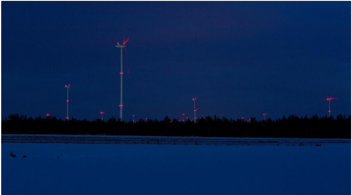
Kuva 93. Kiinteät punaiset lentoestevalot (FCG).
