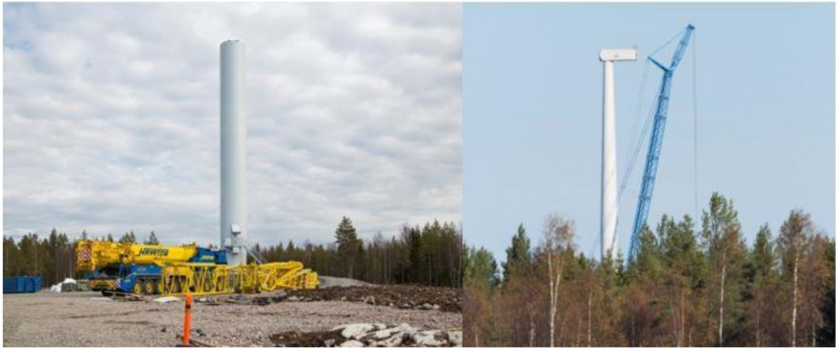
Kuva 102. Tuulivoimalan kokoamista (FCG).
