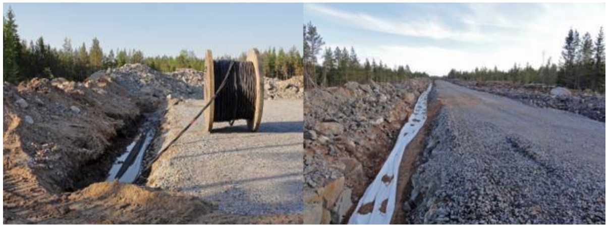
Kuva 100. Maakaapelit upotetaan huoltoteiden yhteyteen (kuvat: FCG).
