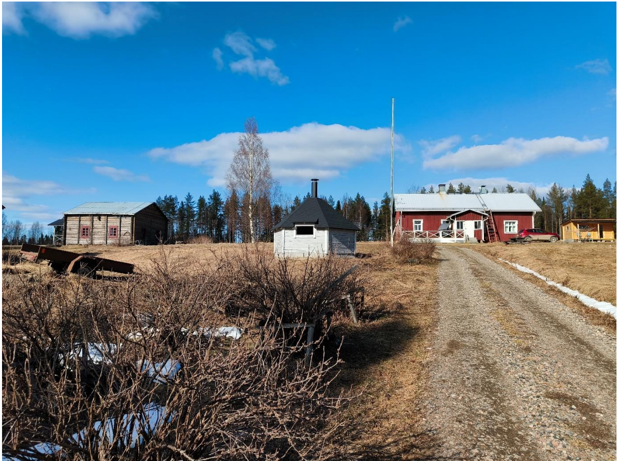
Kuva 8 Tahvin tilan rakennuskantaa. (Kuva: Jyrki Mäkelä FCG)
