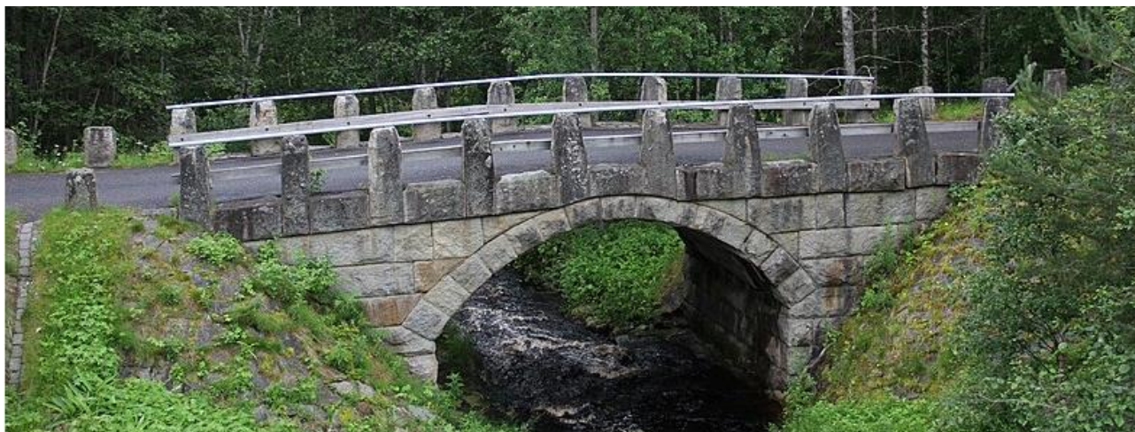
Kuva 6-18: Möykkysenjoen museosilta, Ristijärvi, Suomi. - Silta kuvattuna yhdystien uudelta sillalta (@Htm)
