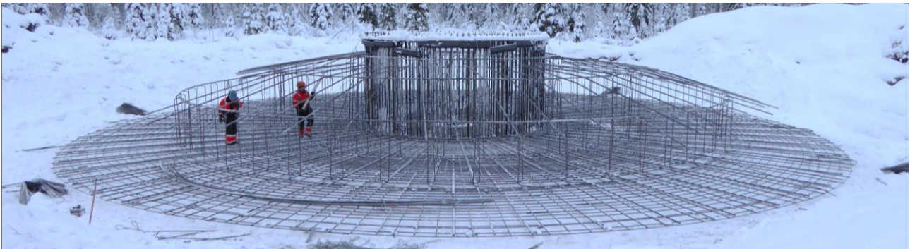
Kuva 4: Tuulivoimalan perustuksen raudoitusta.
