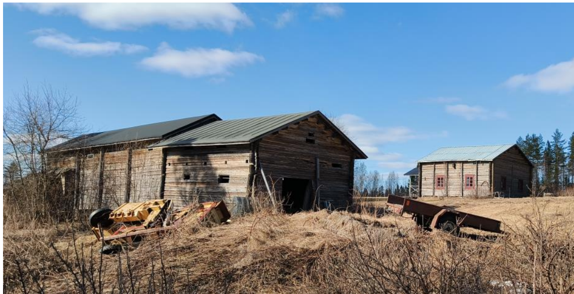
Kuva 16 Aittarivi ja talli kuvattuna etelästä. Taustalla näkyy Kallen puolen asuinrakennus.
