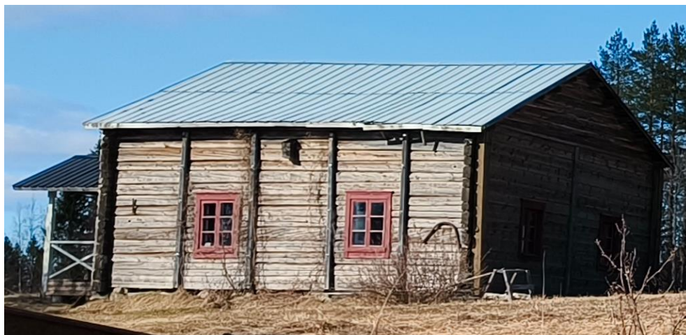
Kuva 14 Kallen puolen 1800-luvun asuinrakennus kuvattuna etelästä.
