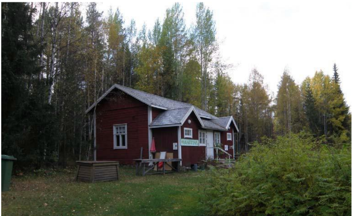
Kesäteatterialueelle huolto- ja kahvilarakennukseksi siirretty entinen asuinrakennus.
