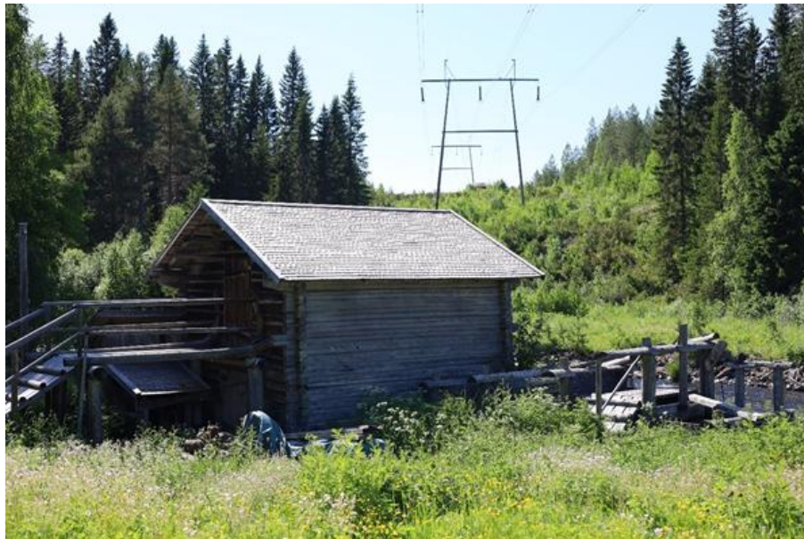
Kuva 4-18. Torvenjoen varrella sijaitse Karppalan mylly. Taustalla näkyy myllyalueen ylittävä 220 kV sähkölinja.
